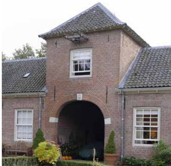
Portgebouw van Zuylestein in Leersum
