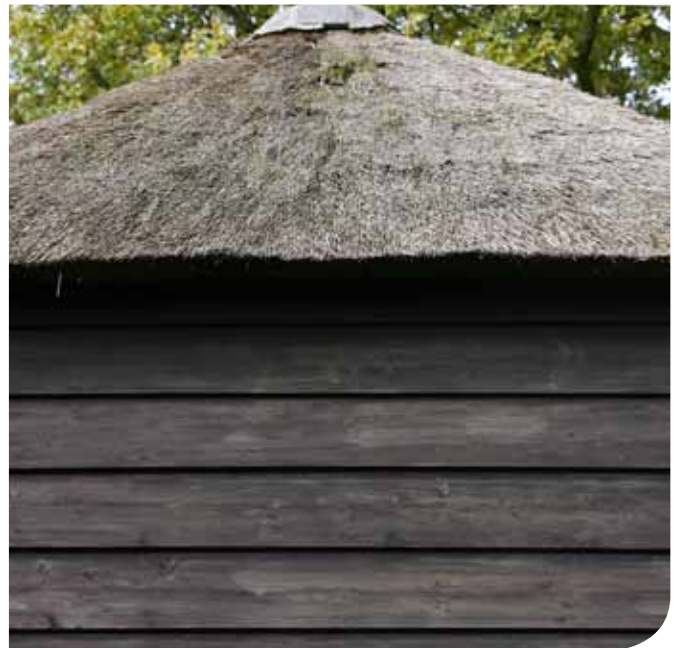
Getrapte weeg of gepotdekselde wand
