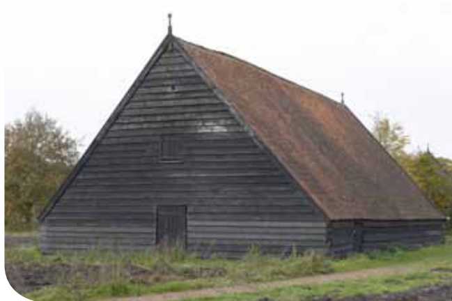
Tabaksschuur in Amerongen
