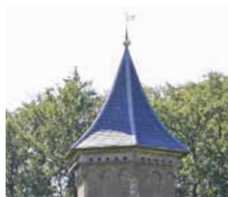
Duiventoren van Sterkenburg met leien dak
